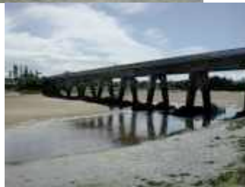
les piles en béton du pont
