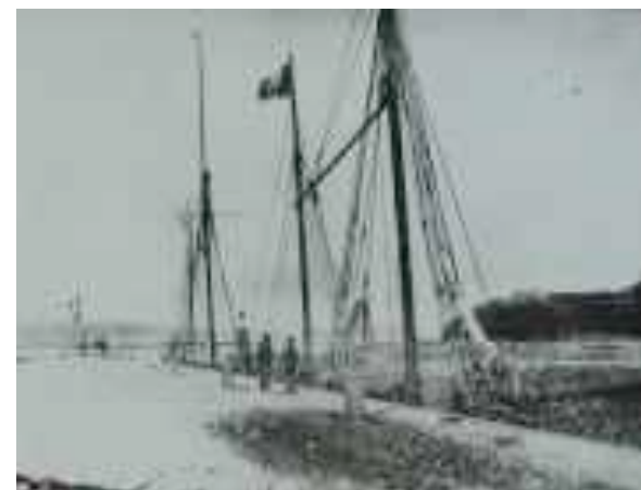
caboteur en décharge au quai
